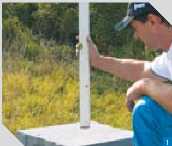
výškové osazení tvárnice
