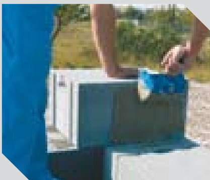
Nanášení zdicí malty na svislou plochu
