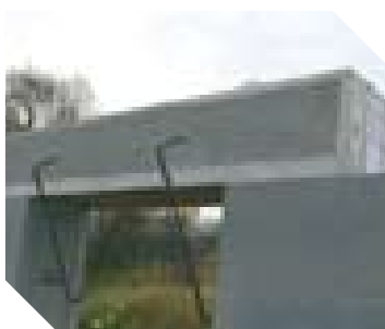
Obr. č. 1 – zabezpečení vyskládaných překladů proti převrnutí
