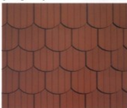
Šupinové krytí (střešní taška bobrovká – drážkovaná)
