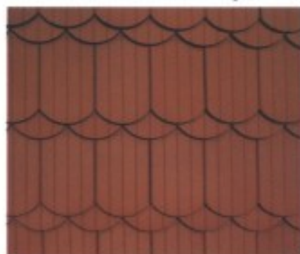
Korunové krytí (střešní taška bobrovká – drážkovaná)
