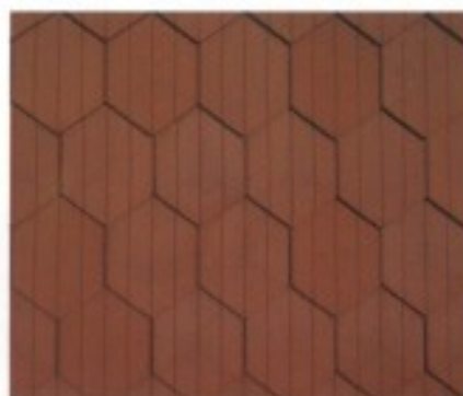
Šupinové krytí (šestiúhelná taška drážkovaná)
